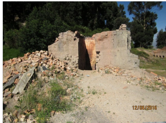
Fotografías Nos. 4 y 5. Antigua Ladrillera Los Cerezos Se aprecian los hornos tipos árabes en proceso de desmantelamiento.
