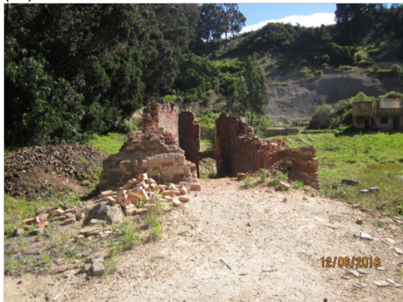
Fotografías Nos. 4 y 5. Antigua Ladrillera Los Cerezos Se aprecian los hornos tipos árabes en proceso de desmantelamiento.
