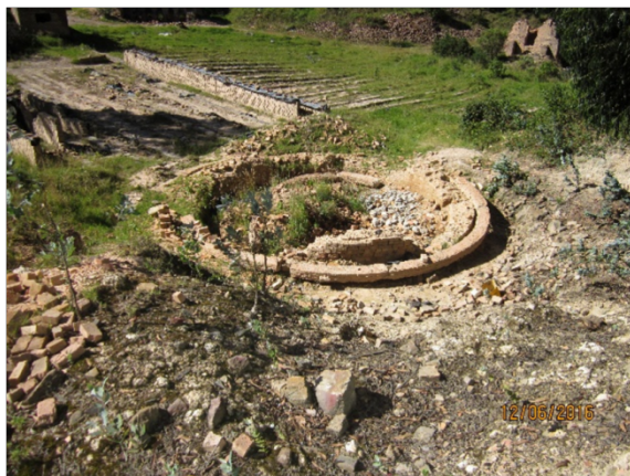
Fotografías Nos. 4 y 5. Antigua Ladrillera Los Cerezos Se aprecian los hornos tipos árabes en proceso de desmantelamiento.
